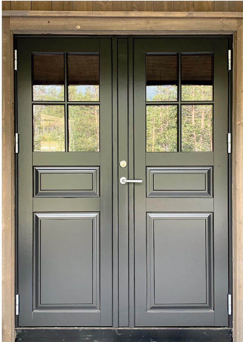
Døme på 2-fløya ytterdør av typen Energi Design, med dobbel slaglist og friste fyllingar. **Energi Design** er ein type vindu og dør som liknar iSOKiTT®, men med smalare fuger og som oftast utanpåliggande klipssprosser.
